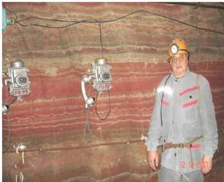
Рис. 14. Телефонная связь в подземной выработке
