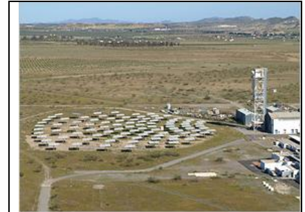
© DLR: Zukunftsweisende Technik? Die DLR-Versuchsanlage im spanischen Almería
