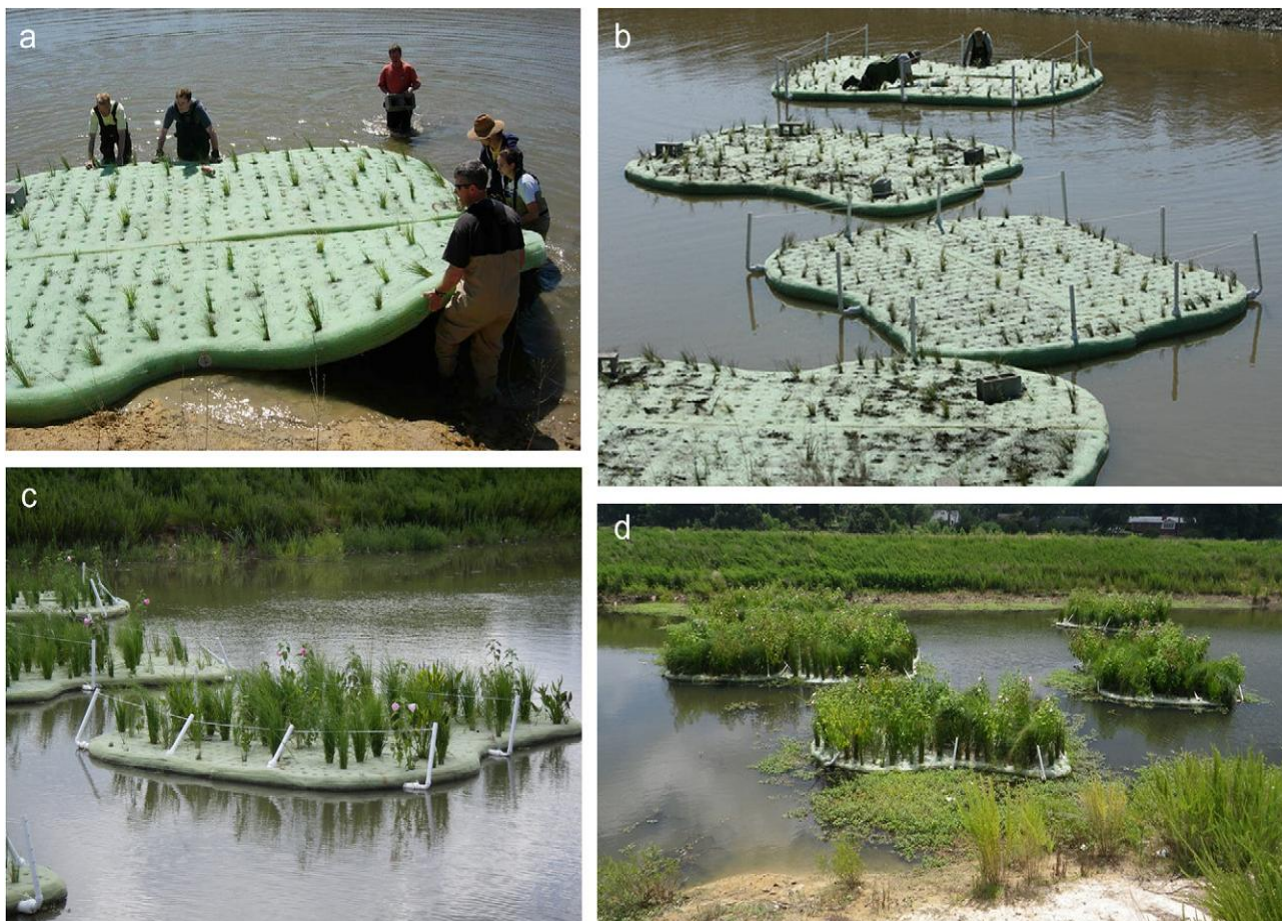
Рис. 2.1.33. Схема организации плавающих биоплато и пример их использования на практике: а) запуск биоплато; б) установка ограждений от растительноядных птиц; с) биоплато через 4 месяца; д) биоплато через 13 месяцев (Winstonetal., 2013)
