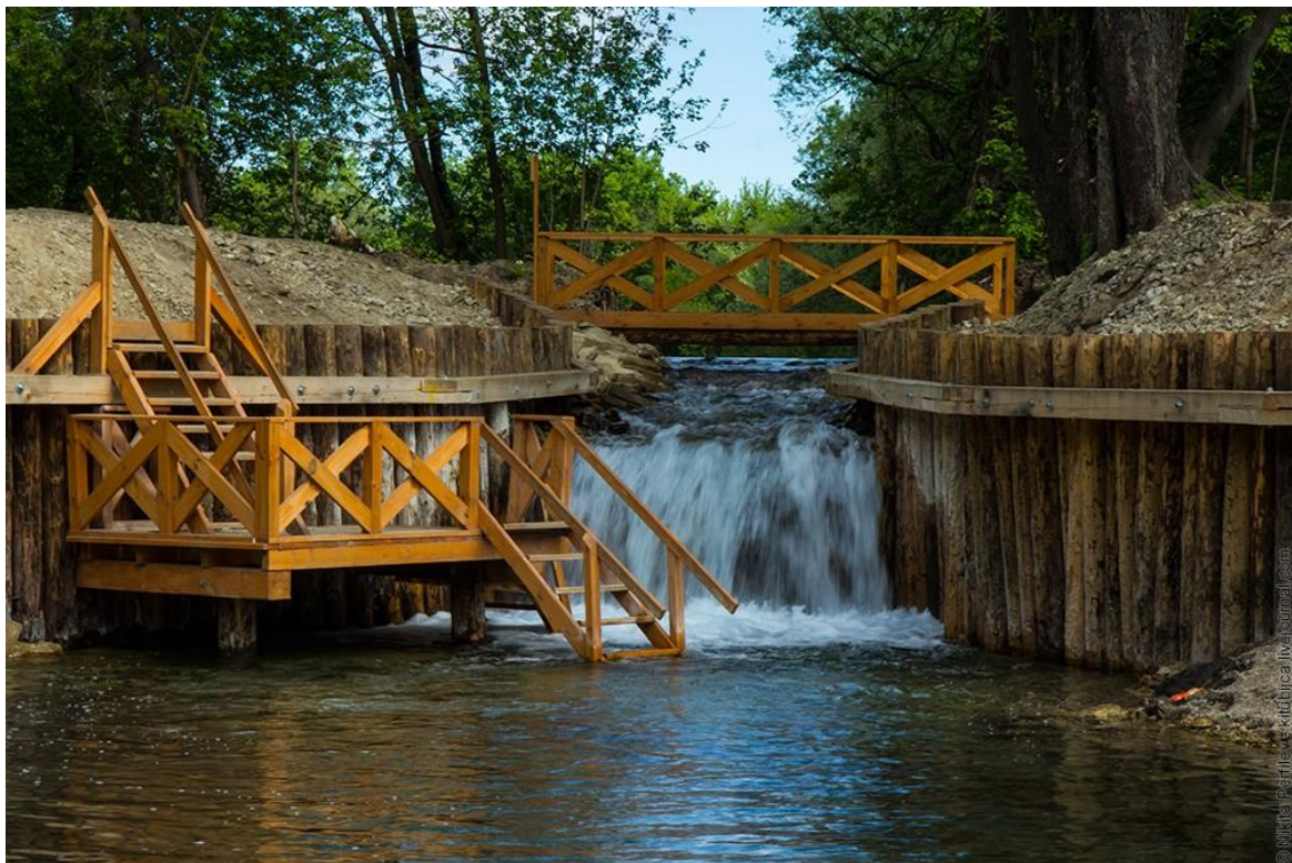
Рис.2.1.3. Укрепление берегов при помощи вертикальной стенки из лиственничных свай (Неизвестный Татарстан..., 2013)
