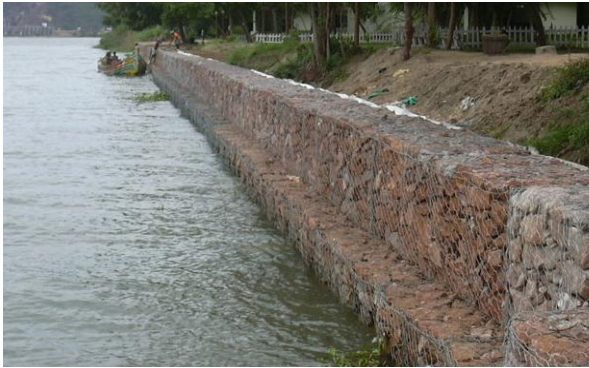
Рис. 2.1.2. Береговая линия, укрепленная габионами (Укрепление..., 2011)
