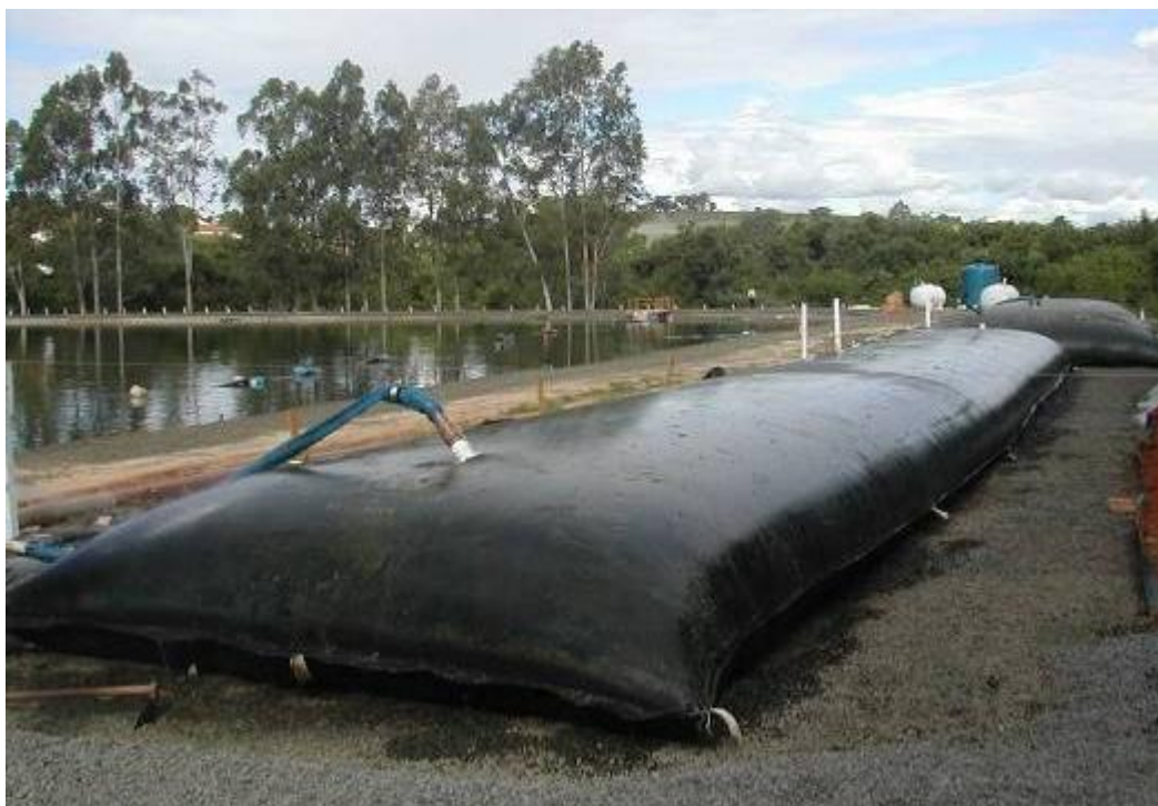
Рис. 2.1.27. Один из способов обезвоживания изъятых донных отложений с помощью технологии Geotube™ ( www.dewateringsolutions.net )
