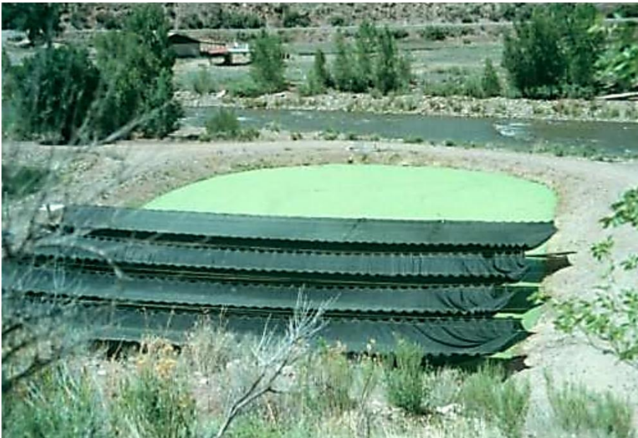
Рис. 2.2.10. Применение искусственного затенения над частью водоема, Невада, США (Principles of design..., 2011)
