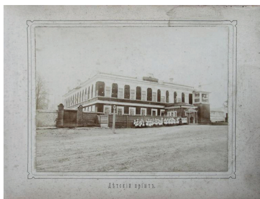
Фото 11. Комплекс зданий Александринского детского приюта
