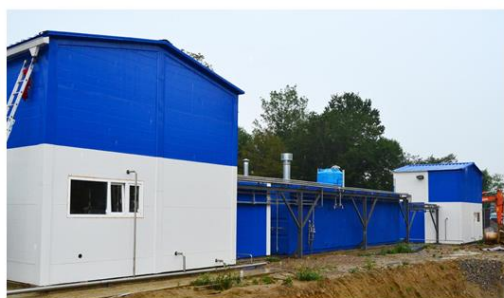
Общий вид зданий: параллельно работающие и технологически связанные Станции очистки стоков (СОС 1 и СОС 2), общей производительностью 400 м 3 в сутки.
